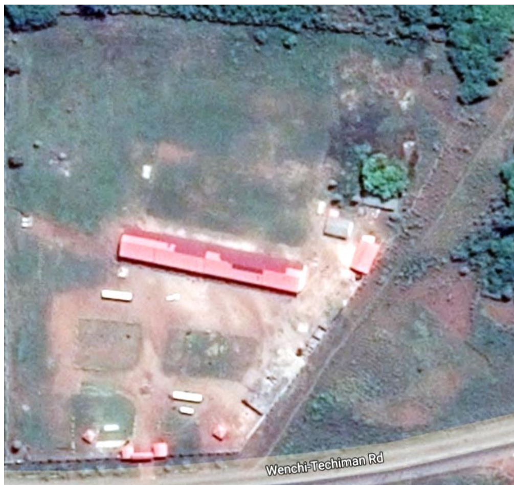
Hierboven de eerste satellietfoto uit 2017 waarop we de school konden zien. De kleurenverschillen van het dak tonen de reparatie van de stormschade. Het voetbalveld achter de school is nog groen dus de opname is nog in het regenseizoen gemaakt. Hieronder de school in de droge tijd (december — februari).
